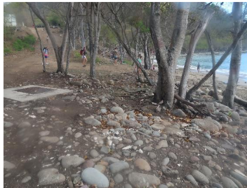
Figure 12 : Illustration des travaux déjà effectués (Terre-de-Haut, Les Saintes)
