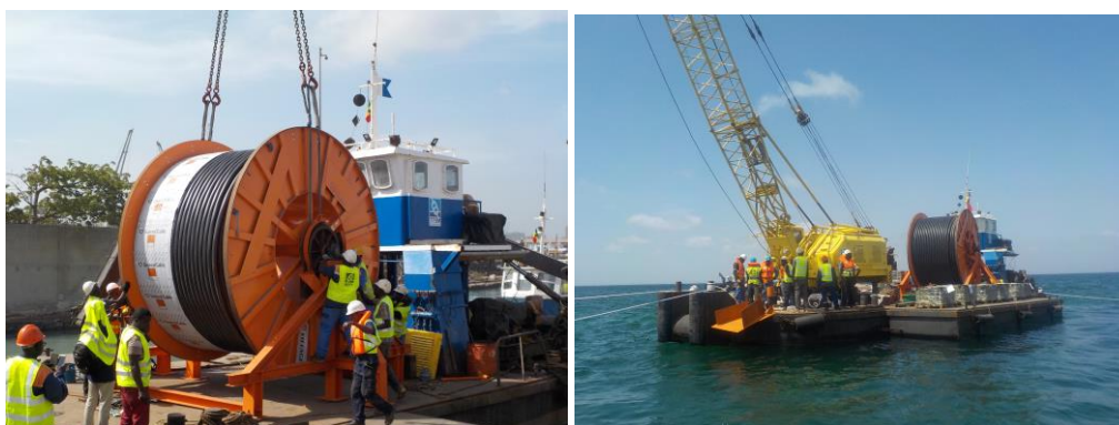
Figure 17 : Navire câblé au cours d'une opération d'atterrage
