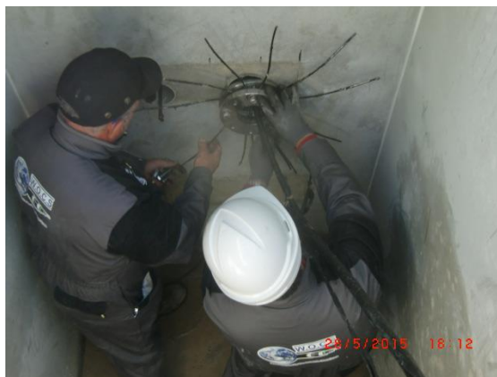
Figure 19 : Intérieur d'une chambre de plage
