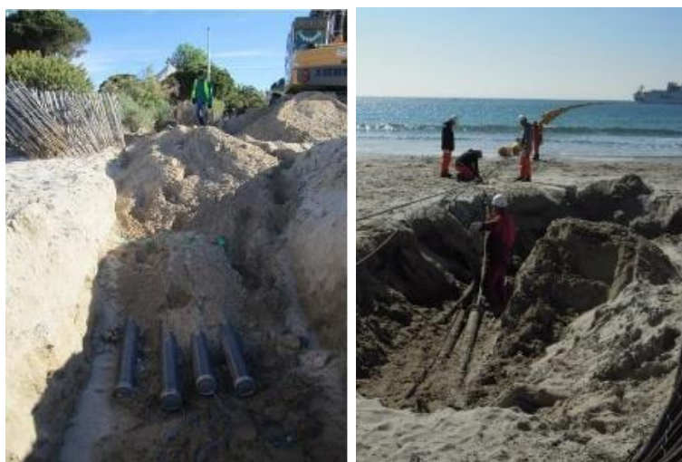
Figure 16 : Exemple d'illustrations de l'installation de conduites d'accueil en haut de plage (à gauche), puis de conduites dégagées à l'occasion de travaux préparatoires à la réception d'un câble (à droite)
